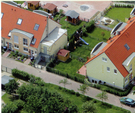
Ökologische Bauweise liegt im Trend, auch ohne dass dabei auf Optik und Komfort verzichtet werden muss: Einfamilienhussiedlung von Waldner Wohnungsbau in Langenfeld.
