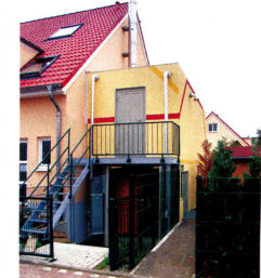
Unsichtbare Energiequelle: Die zuverlässige Holzpelletsheizung versorgt in Langenfeld-Immigrath 38 Häuser mit Wärme.
