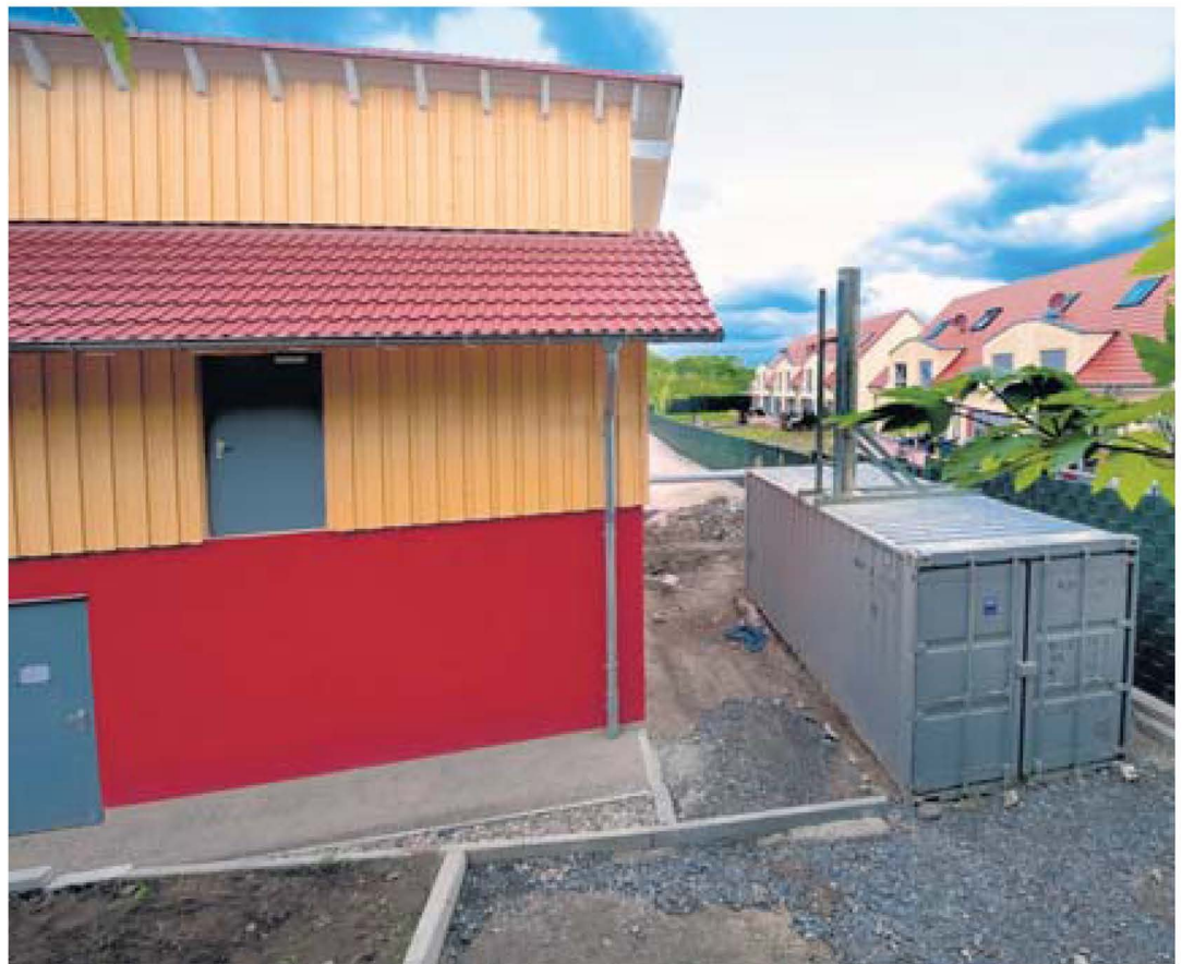
In diesem rot-ockerfarbenen Gebäude wird die zentrale Holzpellet-Anlage installiert. Zur Notversorgung für den Fall, dass sie im Winter mal streiken sollte, steht zusätzlich ein Ölkessel bereit.
